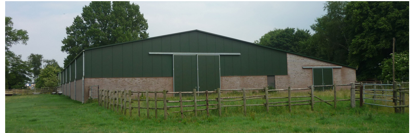
Afbeelding: noordzijde loods, wordt aangeplant met houtwal.
