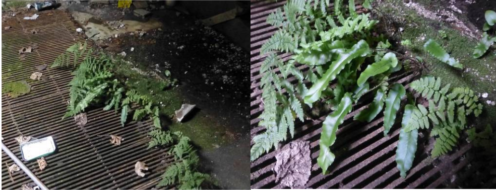
Figuur 9. Aangetroffen tongvaren in één van de stallen.
