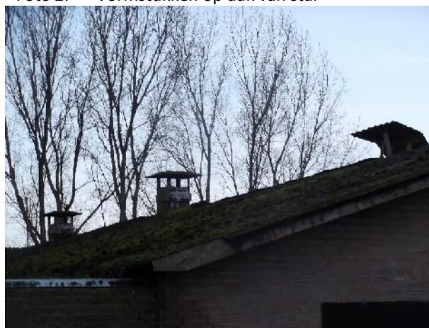
Foto 2: Vormstukken op dak van stal
