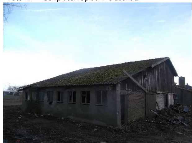
Foto 2: Golfplaten op dak veldschuur
