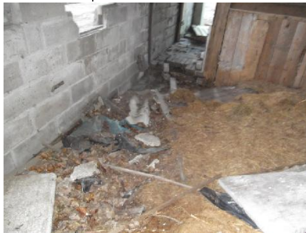
Foto 2: Golfplaat en restanten in veldschuur
