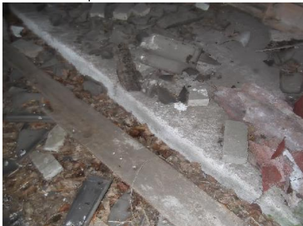
Foto 1: Golfplaat en restanten in veldschuur
