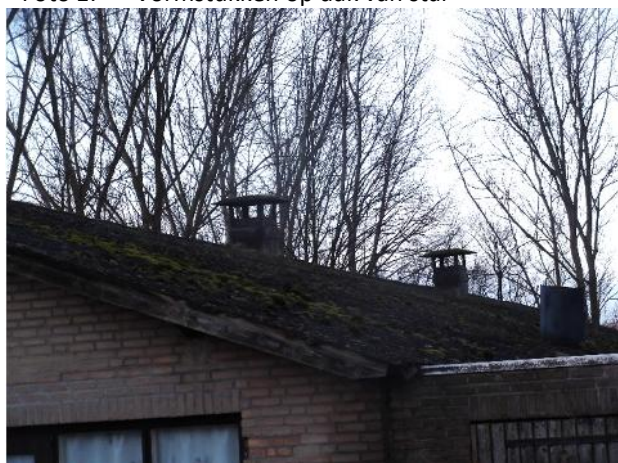
Foto 1: Vormstukken op dak van stal
