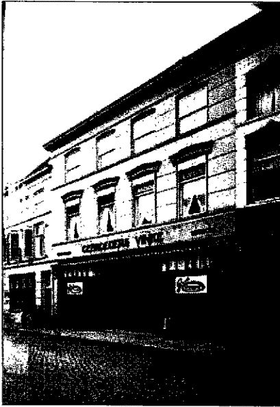
Figuur 4: De voorgevel vóór 1933
