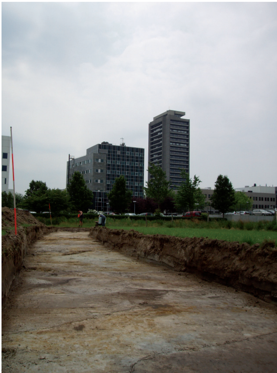
Afb. 2. Werkzaamheden in proefsleuf 1.
