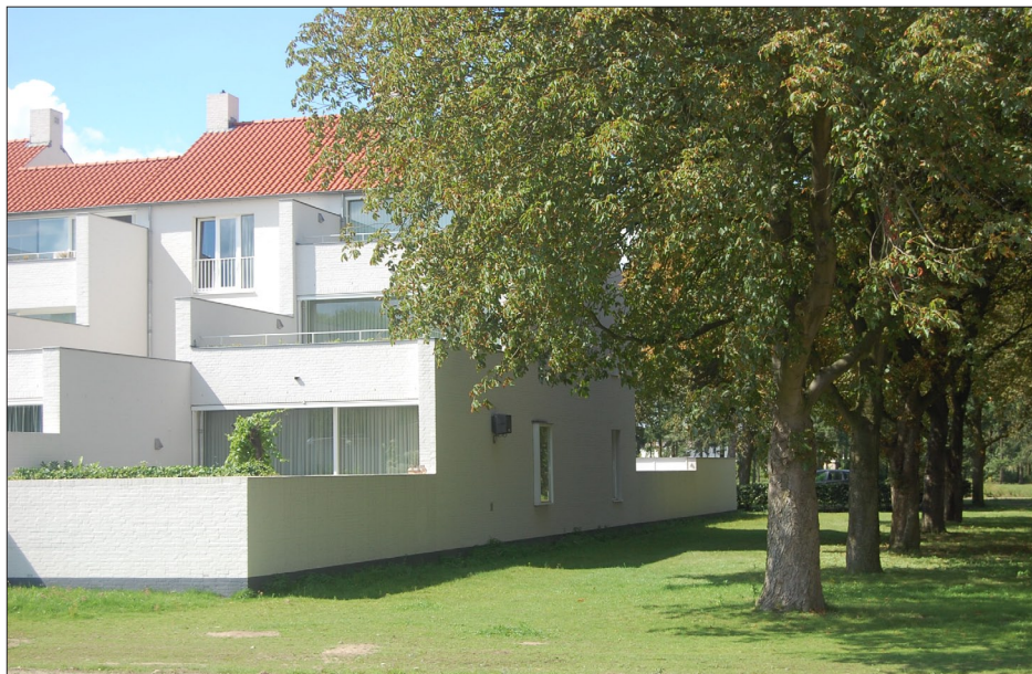
lichte kleurstelling en aansluiting maaiveld
