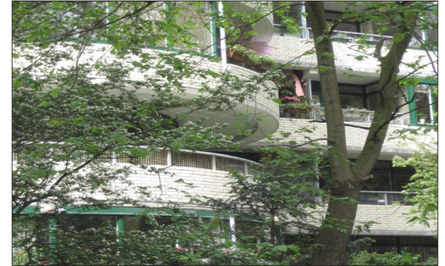
combinatie bomen en wit metselwerk
