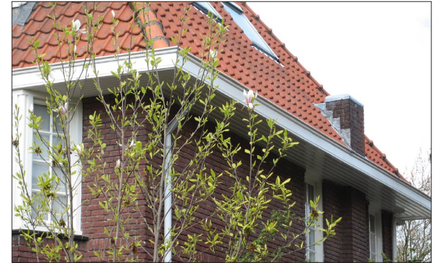
overstekken en dakpannen
