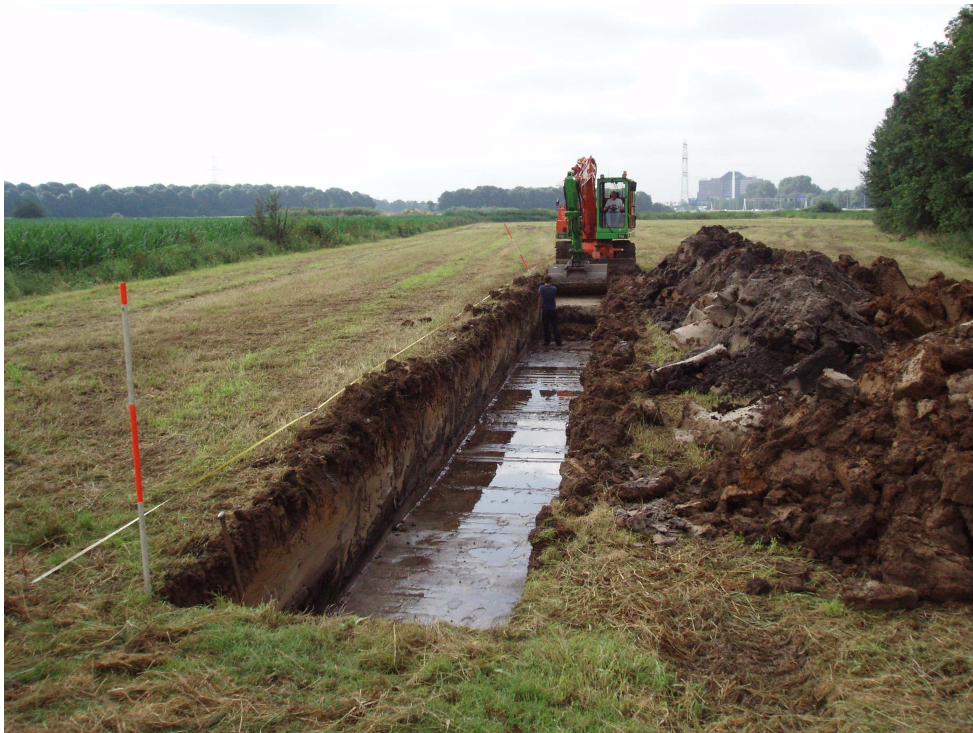
Afb. 2 Aanleg proefsleuf 1; foto richting het zuiden.
