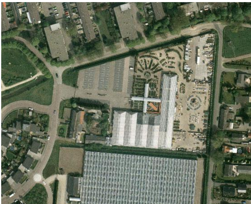
Luchtfoto van het tuincentrum Coppelmans
