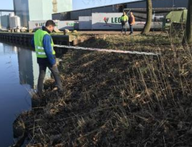
Grastalud c.a. 1:3 c.a. 1m niveauverschil
