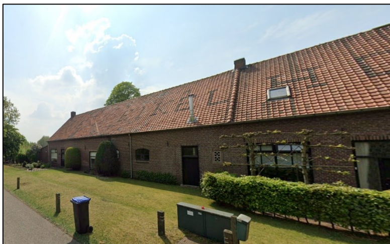
Figuur 10: Vooraanzicht woningen Sluisdijk 1 en 3 [Bron: Google Maps]
