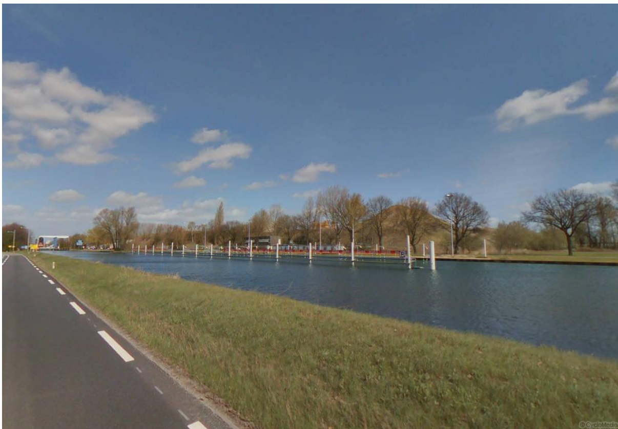
Zicht vanaf de Kanaaldijk ZW op het recycle bedrijf.
