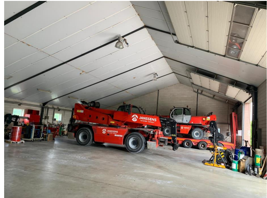
Afbeelding 6: Aanzicht binnen, plafond bestaat uit isolatieplaten
