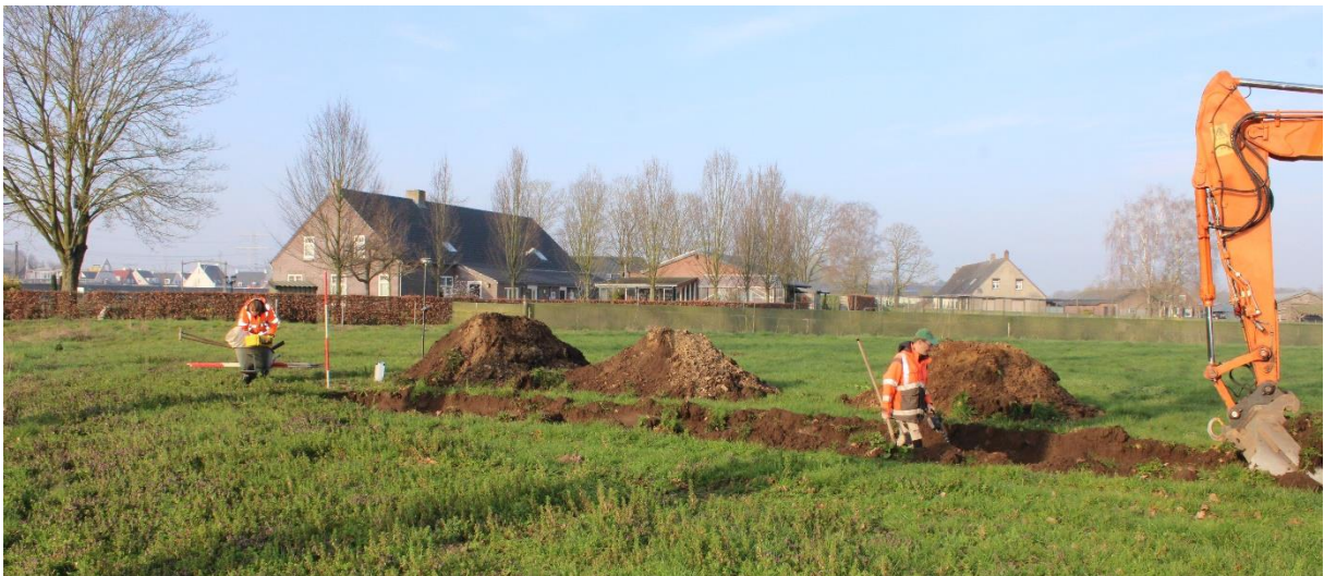
Fig. 1.3. Helmond-Brandevoort-De Voort. Aanleg van de eerste proefsleuf.
