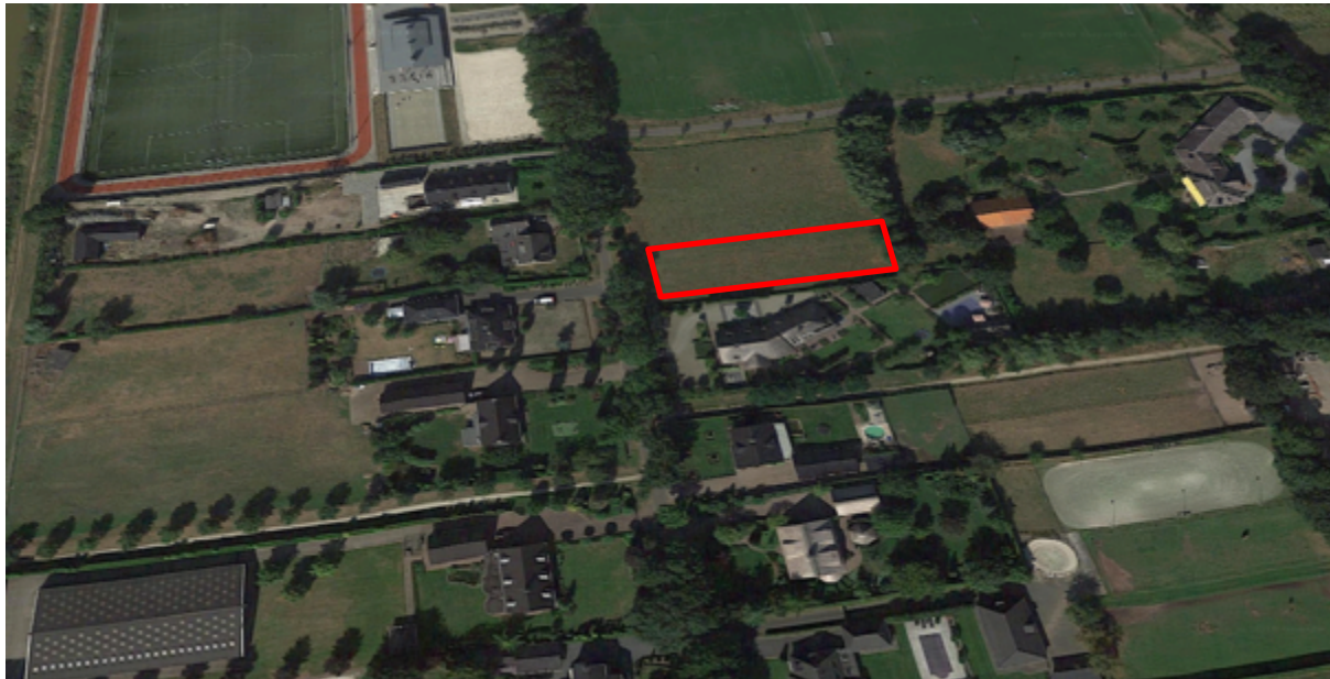
3D- luchtfoto van het perceel aan de Kaldersedijk (bron: google.nl)
