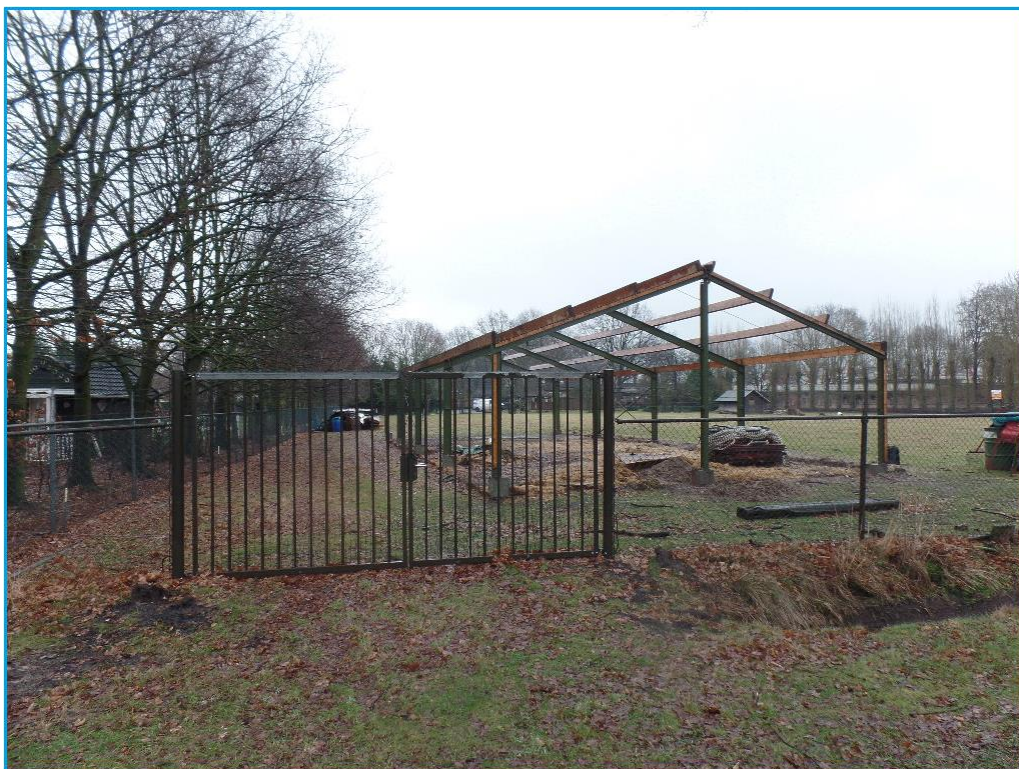
Figuur. Zicht op projectlocatie en deels gedemonteerde schuur, d.d. 14-1-2017
