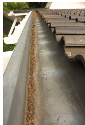
Figuur 3. Dakpannen met vogelwerende maatregelen en dakgoot zonder enige sporen van vogels.
