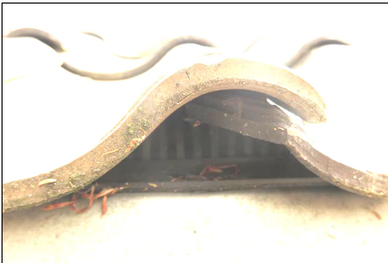
Figuur 3. Dakpannen met vogelwerende maatregelen en dakgoot zonder enige sporen van vogels.
