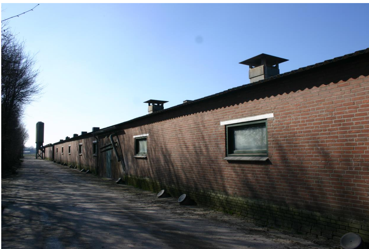
Figuur 3. Zicht op de varkensstallen.
