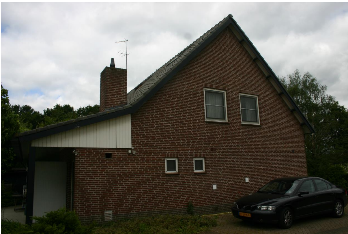
Figuur 2. De zijgevel van het woonhuis.
