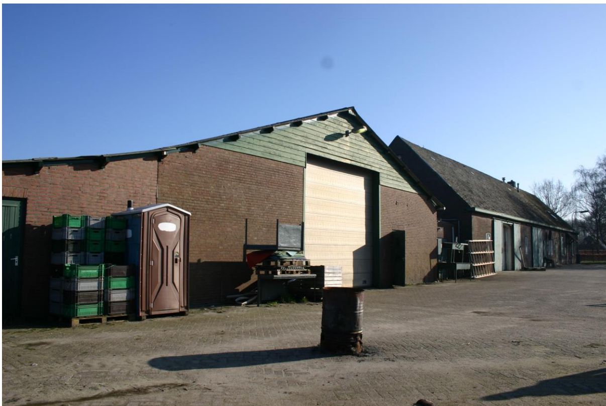
Figuur 2. De te slopen gebouwen op locatie Diepenbroek 4 te Helmond.
