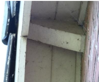
Figuur 8. Overhangende dakpannen, geschikt voor gewone dwergvleermuis.
