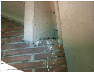
Figuur 7. Geschikte opening naar de spouwmuur.
