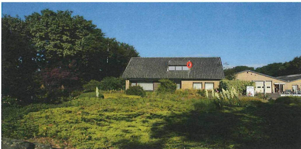
Foto 4: locatie van de nestplaats van de Huismus onder de dakpannen van de dakkapel (rode cirkel).
