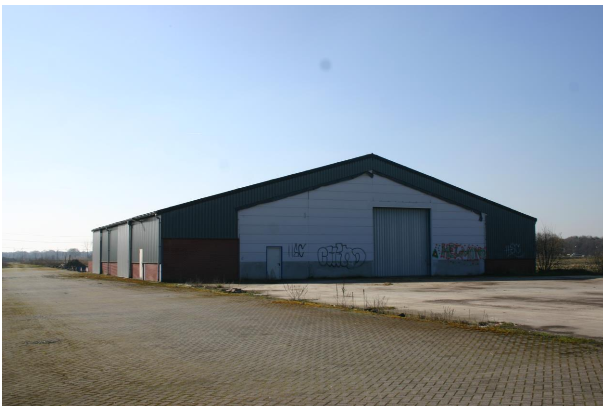
Figuur 5. De deels afgebroken loods
