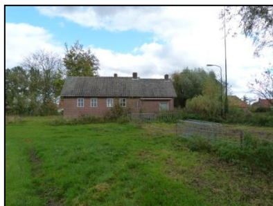
Figuur 7. Oostzijde onderzoekslocatie.
