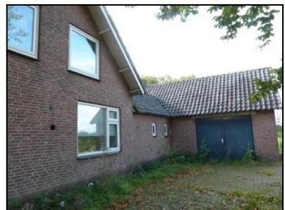
Figuur 5. Oprit met garage noordwestzijde onderzoekslocatie.
