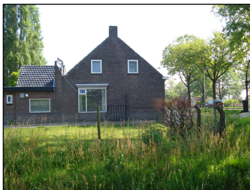
Foto 3: te slopen woonhuis
