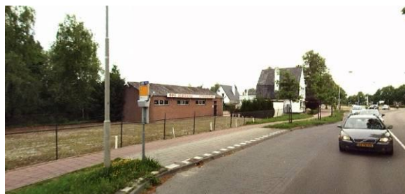
Te amoveren bedrijfsbebouwing Geldropseweg
