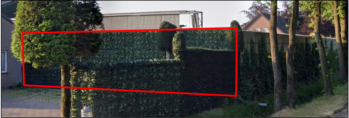
Figuur 10: Zijaanzicht planlocatie met aan de linkerzijde een groen aangeklede schutting.
