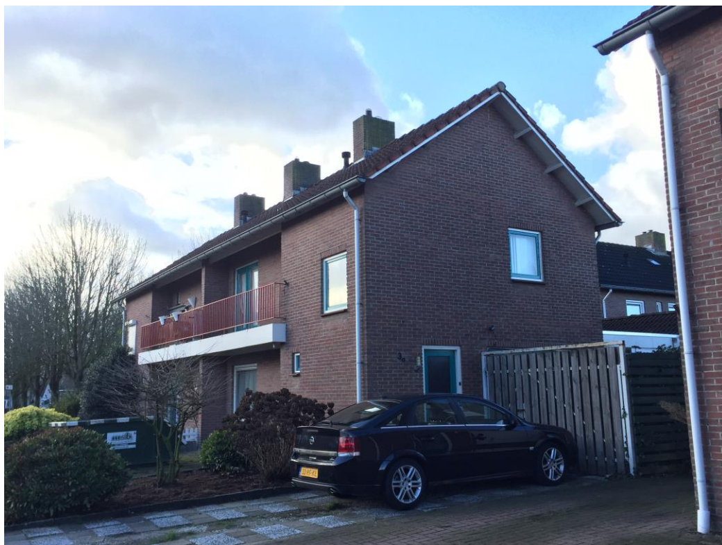
Figuur 1.3 Woningen aan de Van der Weidenstraat 1-11 A
