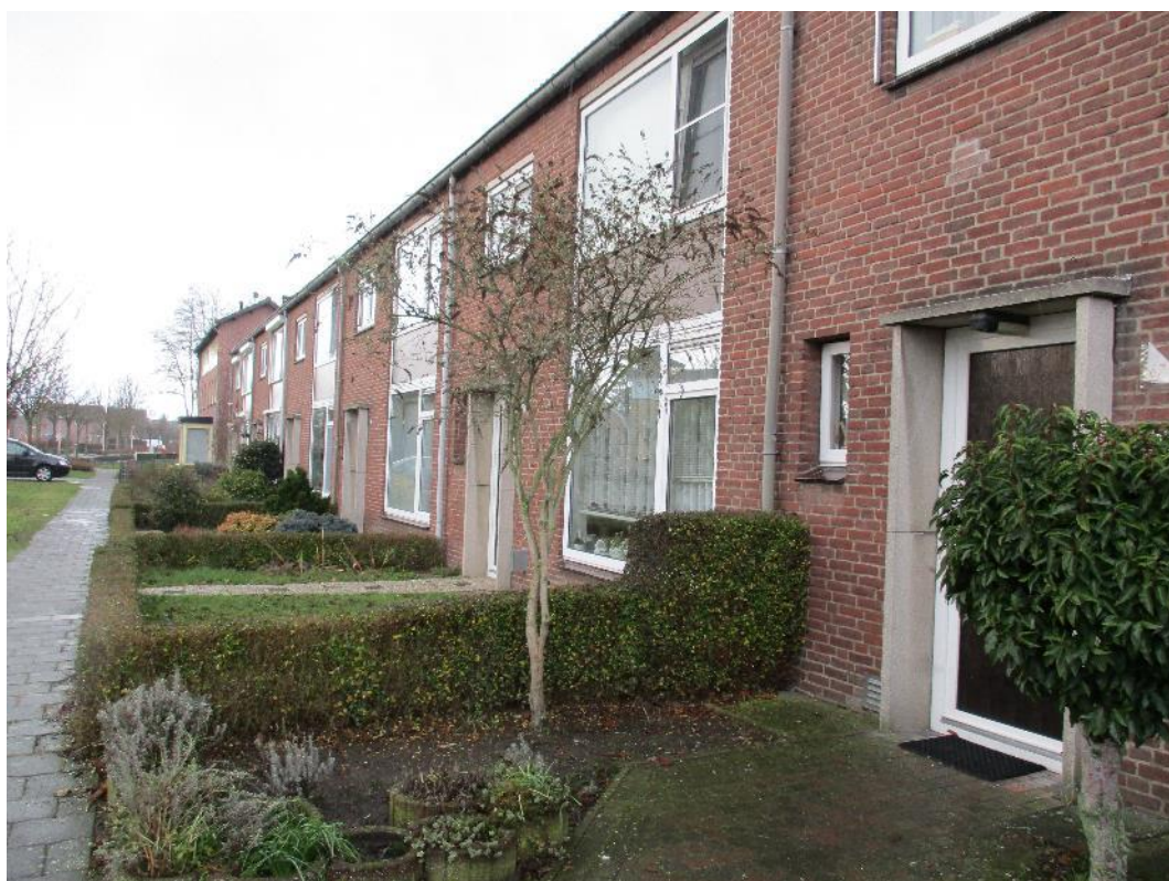
Figuur 9 De planlocatie aan de Pastoor Elsenstraat betreft enkele rijtjeswoningen bestaande uit twee bouwlagen.
