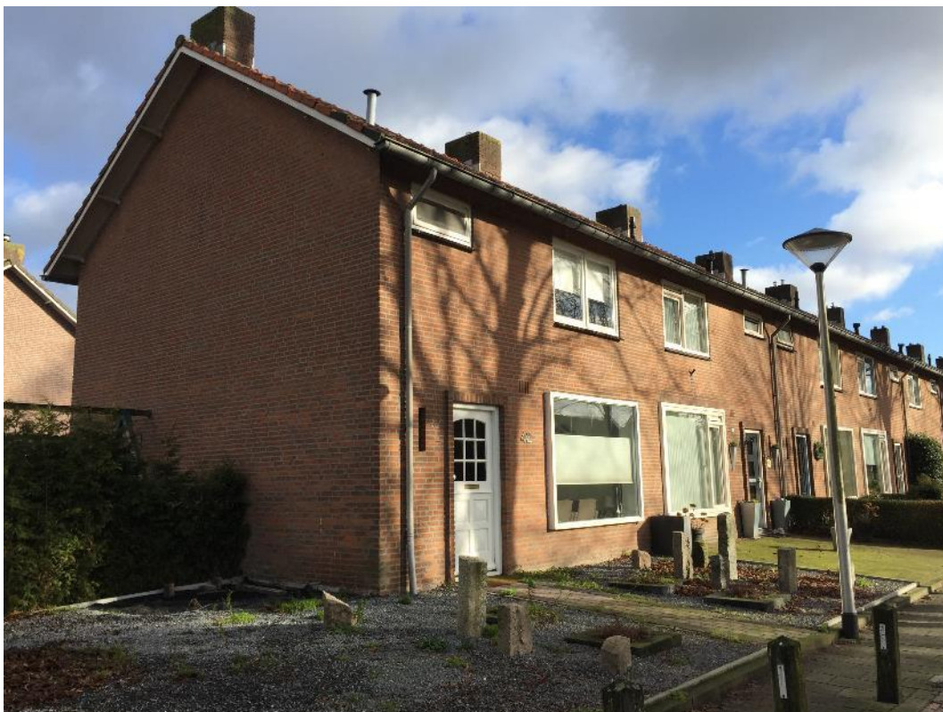
Figuur 20 De planlocatie aan de Lieshoutseweg betreft enkele rijtjeswoningen bestaande uit twee bouwlagen.
