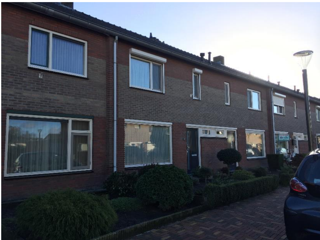
Figuur 25 Aan de Margrietstraat zijn ook rijtjeswoningen gesitueerd bestaande uit twee bouwlagen.
