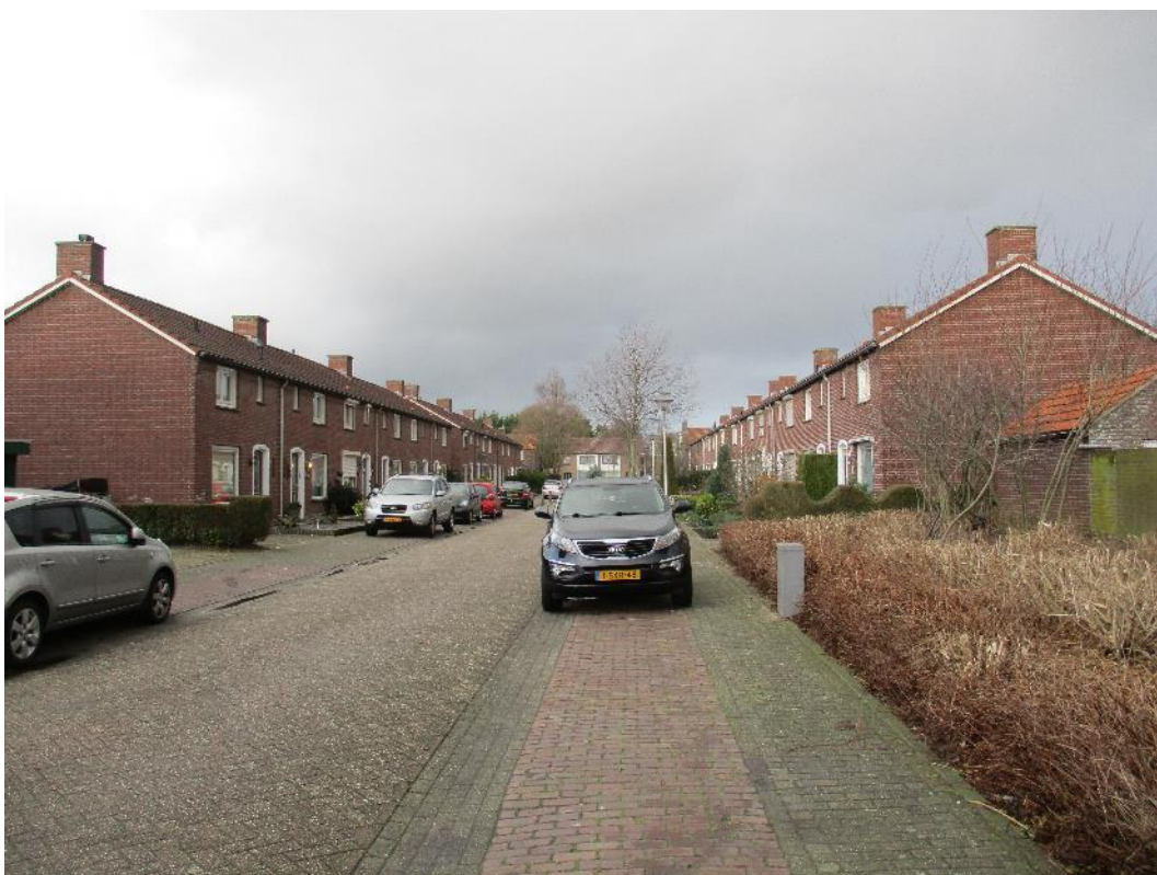
Figuur 13 De planlocatie aan de Pastoor Strijboschstraat betreft enkele rijtjeswoningen bestaande uit twee bouwlagen.
