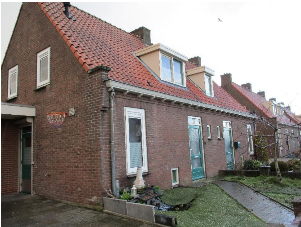
Figuur 14 De planlocatie aan de Pater van Vlerkenstraat betreft enkele rijtjeswoningen bestaande uit een bouwlaag.
