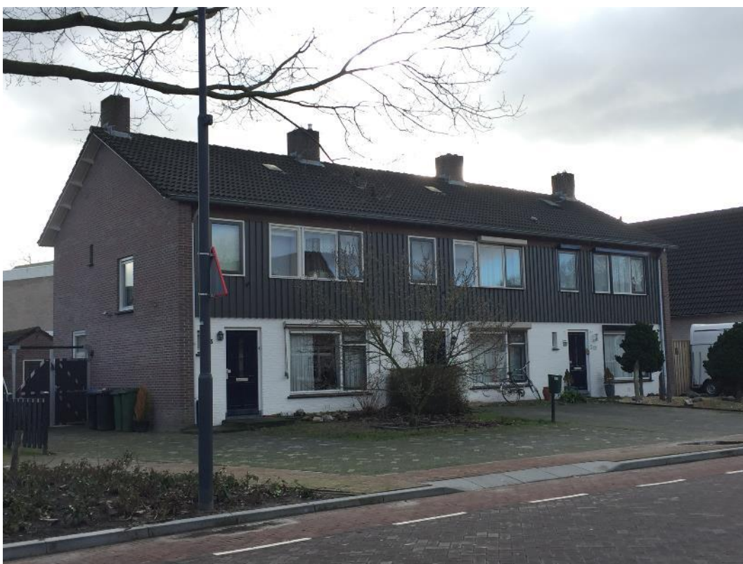
Figuur 21 De planlocatie aan de Gerwenseweg betreft enkele rijtjeswoningen bestaande uit twee bouwlagen.
