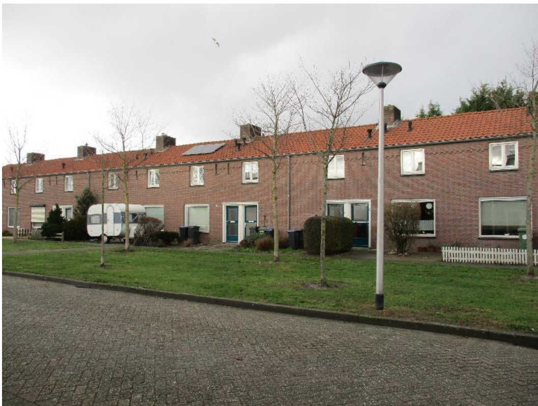
Figuur 12 De planlocatie aan de Pastoor van de Spijkerstraat betreft enkele rijtjeswoningen bestaande uit twee bouwlagen.
