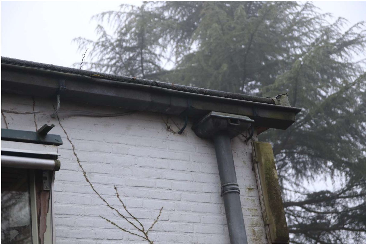
Foto 2: directe boven de dakgoot ligt een bitumen dakbedekking op de muur. Er zijn nergens plekken waar eventuele huismussen onder het bitumen dak kunnen nestelen.
