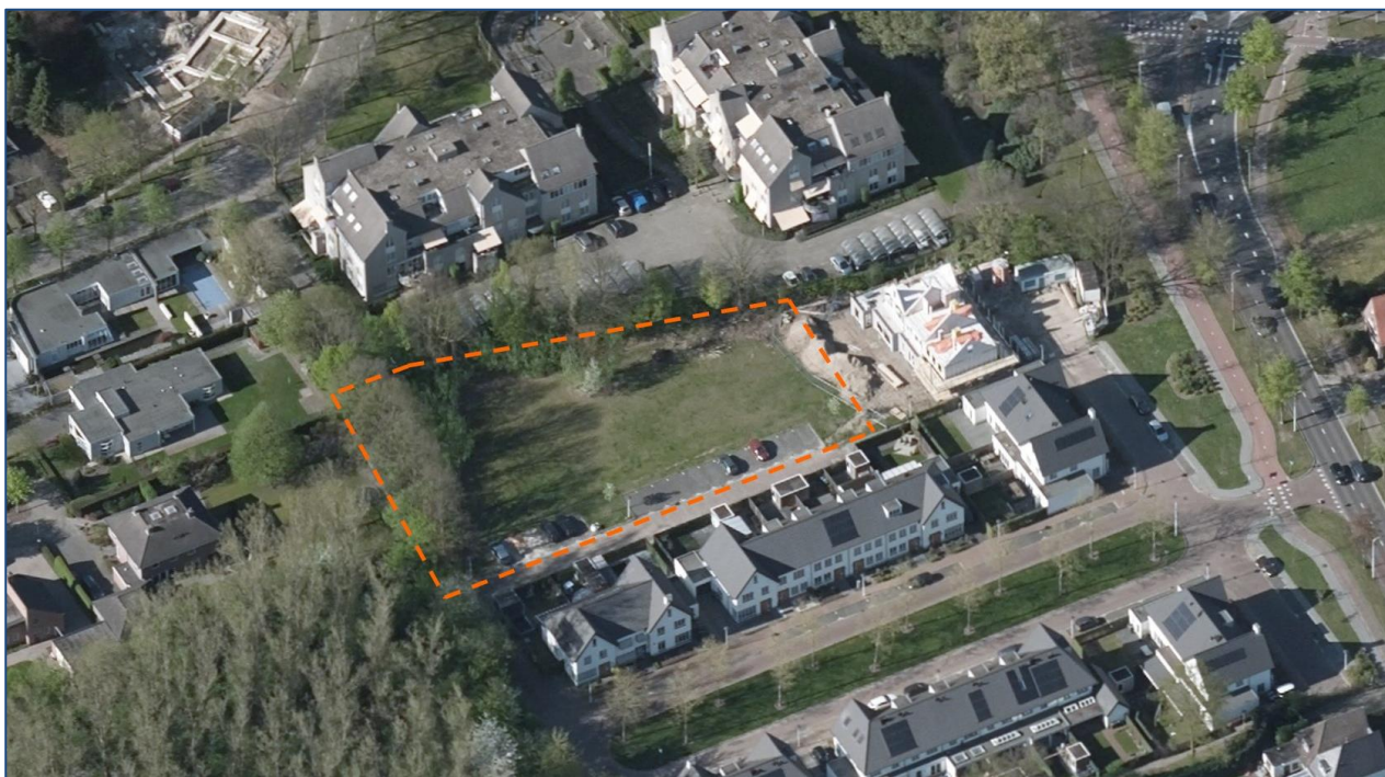
Afbeelding 1.2: Ligging projectlocatie bovenaanzicht vanuit het zuiden gezien (Bron: Globespotter)
