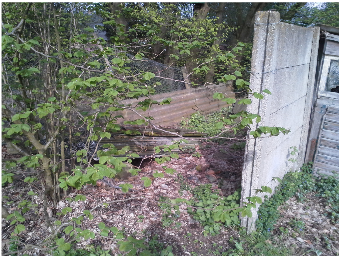
Opslag asbestplaten achter één van de gebouwen – d.d. 16 april 2018
