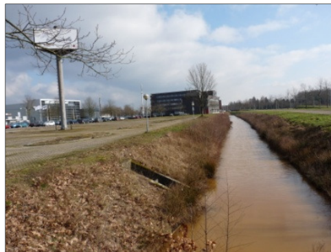
Foto 2 Te verleggen afwateringssloot
