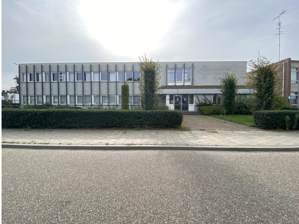
Figuur 3. Beeld van voorgevel (noordzijde).
