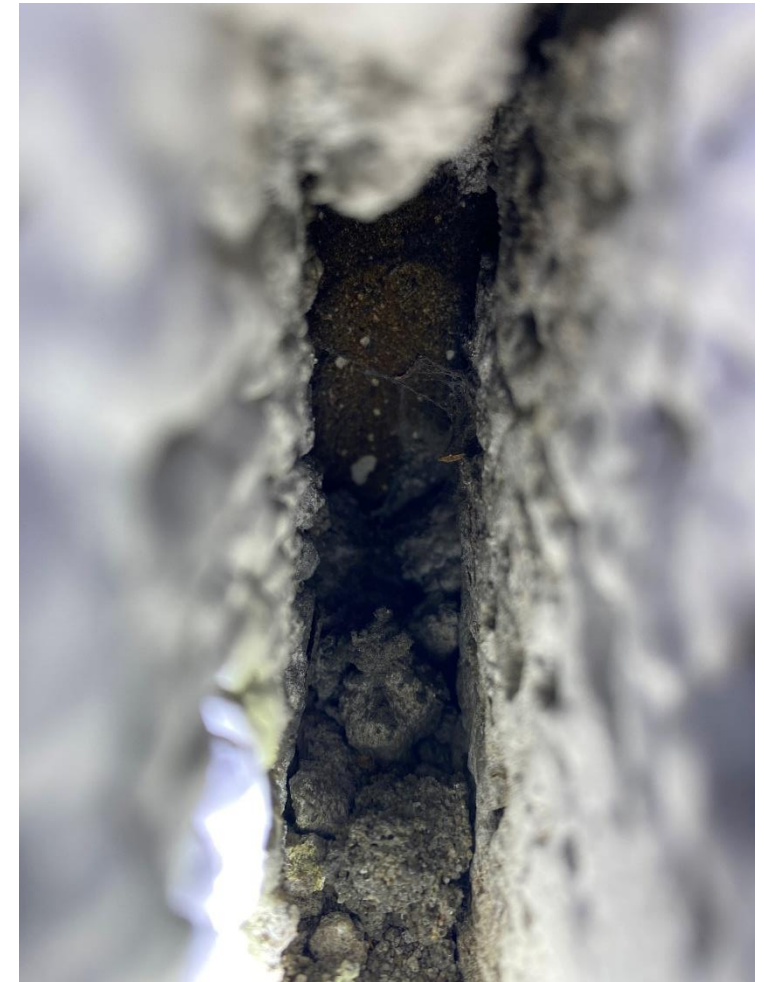
Figuur 20. De enige opening in het gebouw is ondiep en leidt niet tot een spouw. Er zijn hier ook geen uitwerpselen van vleermuizen gevonden.
