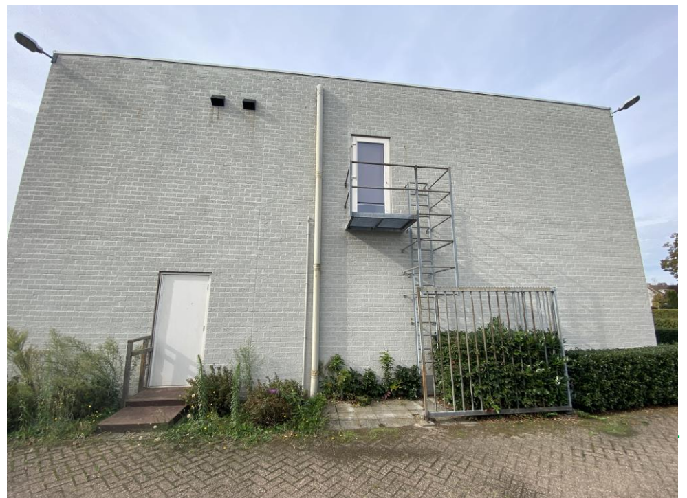
Figuur 6. Beeld van linkerzijgevel (oostzijde).
