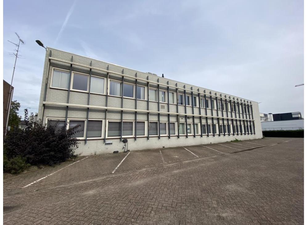
Figuur 5. Beeld van de achtergevel (zuidzijde).
