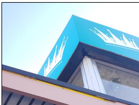
Figuur 11. Opening in daklijst waar vleermuizen gebruik van kunnen maken.
