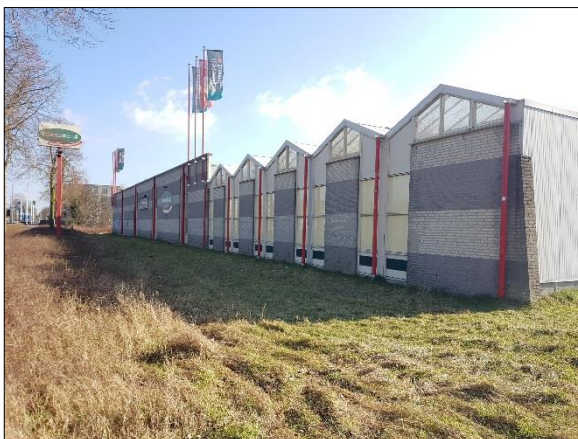
Figuur 5. Deels te slopen gebouw vanuit noordwesten
