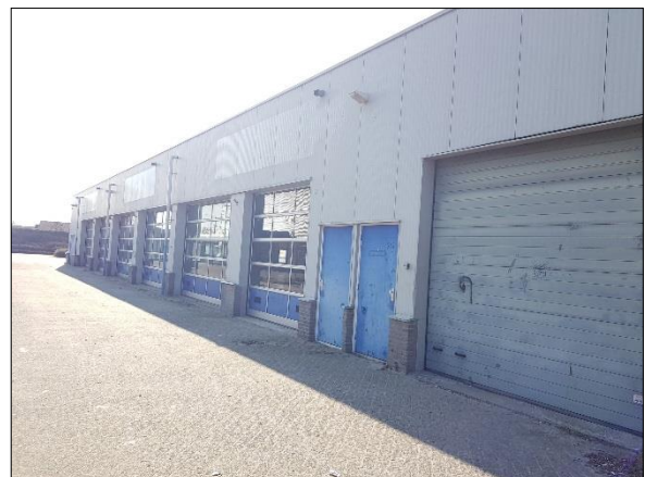
Figuur 6. Deels te slopen gebouw vanuit oosten
