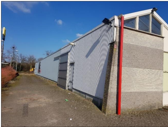
Figuur 7. Deels te slopen gebouw vanuit zuidwesten
