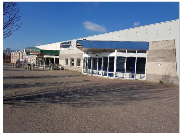
Figuur 4. Deels te slopen gebouw vanuit zuidoosten
