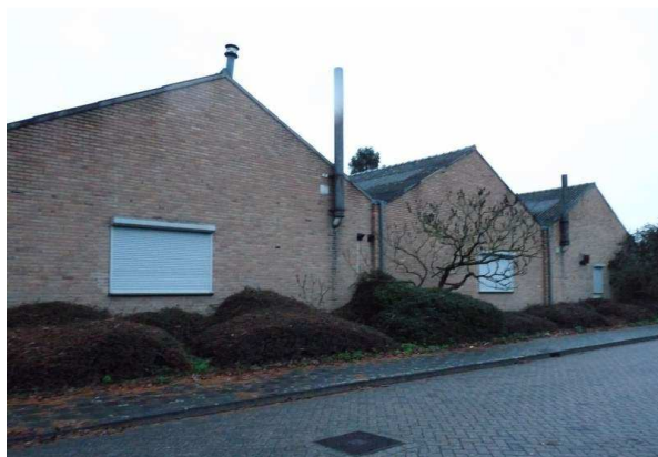
Fig. 9. De drie aan elkaar gekoppelde hallen, gezien vanaf de Prof. Rommelaan. Foto genomen in noordelijke richting.
