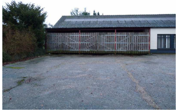
Fig. 4. Het binnenpleintje met de eerste hal met asbest golfplaten dak.
