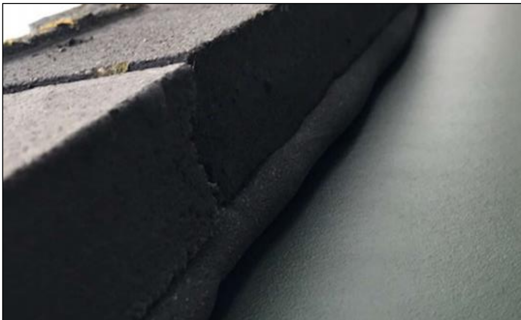
Figuur 3.12 Het gebruik van compribanden tussen kierende kantpannen (Hemubo).
