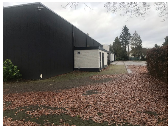
Afbeelding 5. Bedrijfsruimte, deel b van het kantoorgebouw en bestrating aan de zuidzijde van het gebouw.
