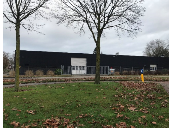
Afbeelding 3. Overzicht van westkant van de bedrijfshal.
