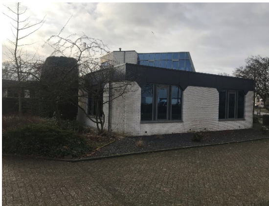
Afbeelding 6. Deel van de oostzijde van het gebied, met zicht op het kantoor.
