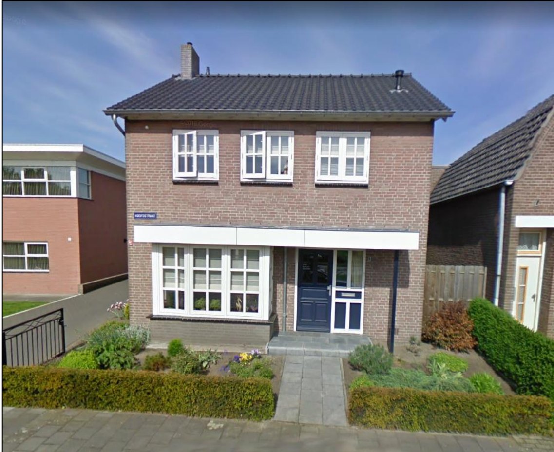
Aanzicht te transformeren bedrijfswoning
