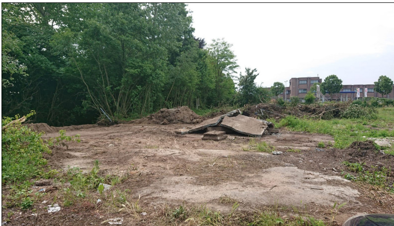
Figuur 1: de gevolgen van de werkzaamheden tijdens het onderzoek; de vegetatie is gerooid.
