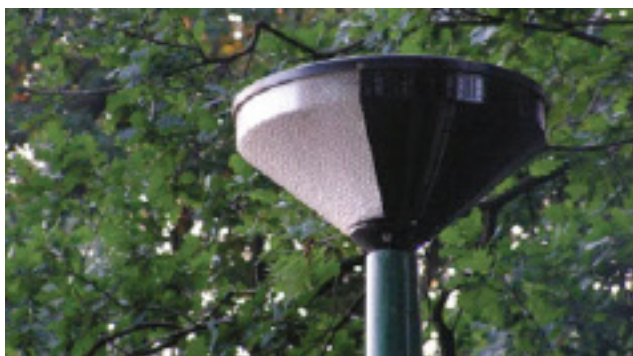
Figuur 2: voorbeeld van een aangepast armatuur waardoor het licht niet naar achter en boven schijnt (Bron: Bij12b, 2017).
