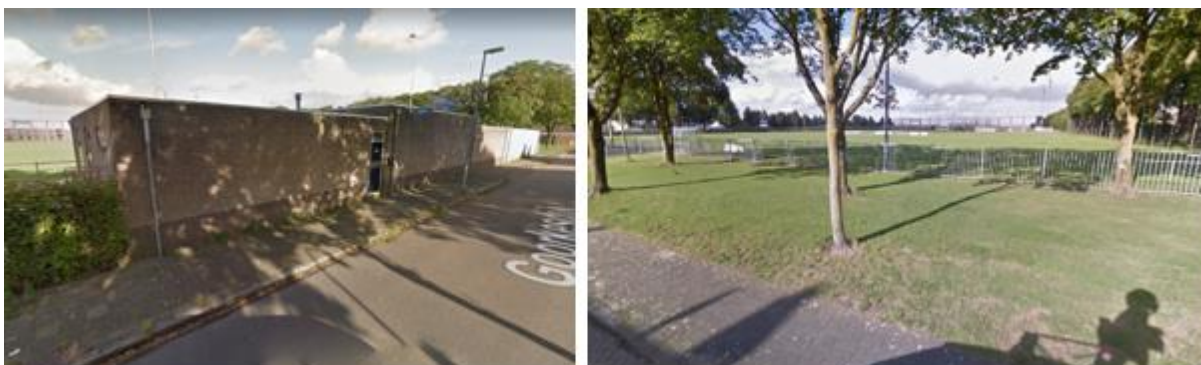
Impressie van een blinde gevel en hekwerk aan de westzijde van het sportpark.
