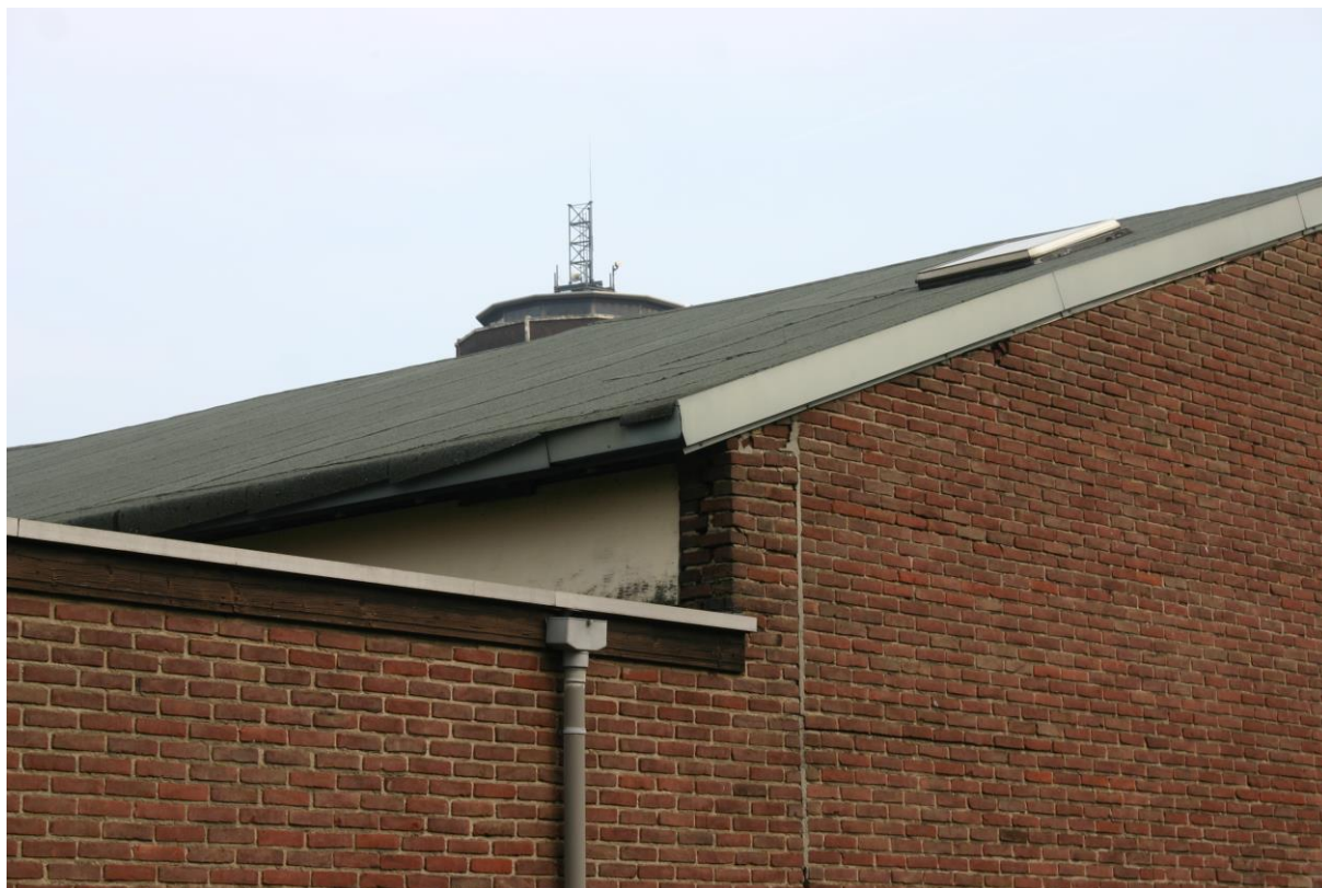
Figuur 4.2. De Gaviolizaal heeft een bitumen dak dat over de zijgevels heen steekt.
