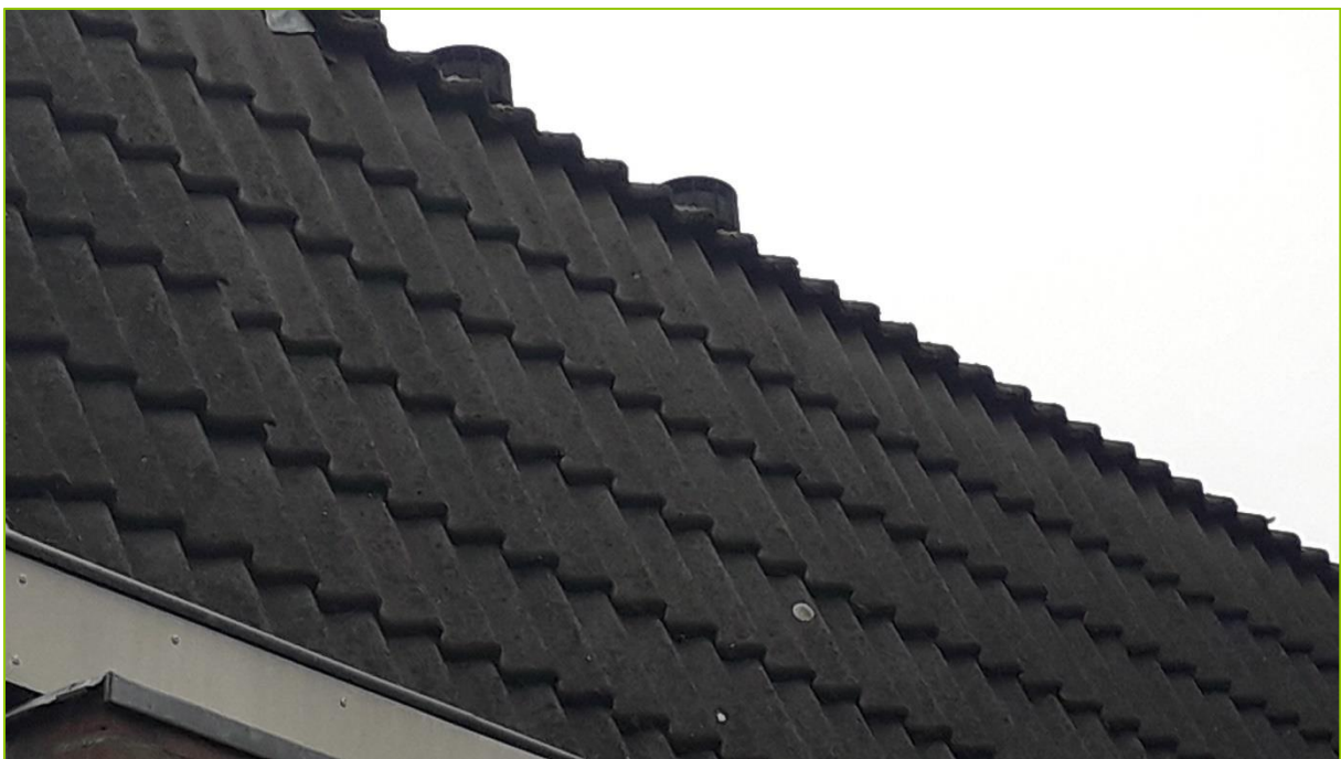
De pannen van het zadeldak sluiten nauw op elkaar aan en zijn afgewerkt met afdichtende loodslabben
