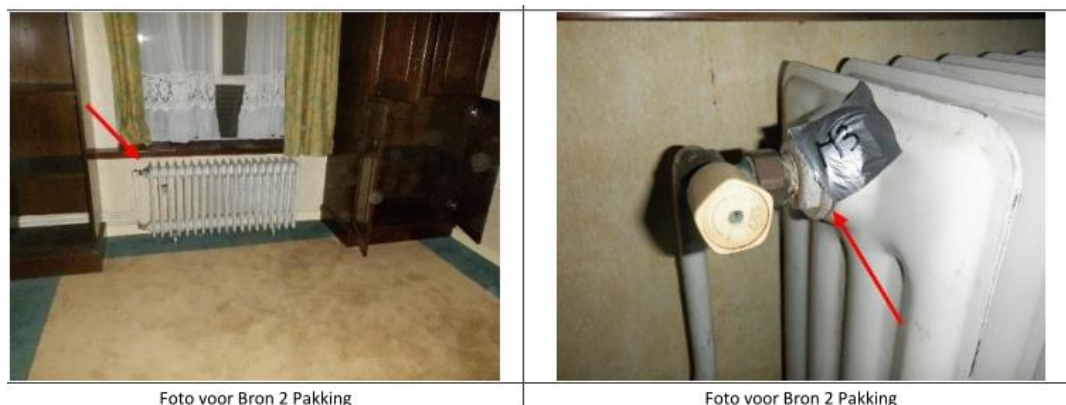
FIGUUR 4.2: ASBESTHOUDENDE PAKKING, UITSNEDE RAPPORTAGE RONTREX
