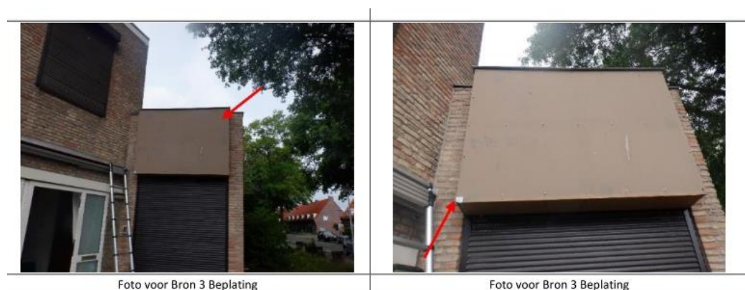
FIGUUR 4.3: ASBESTHOUDENDE BEPLATING, UITSNEDE RAPPORTAGE RONTREX
