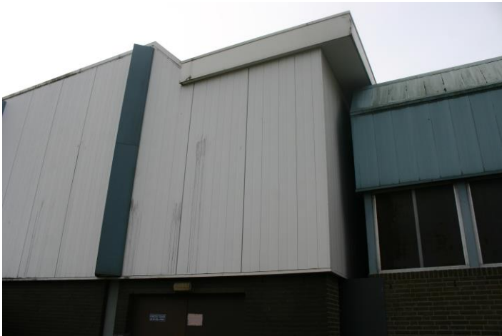
Figuur 4.2.2. De bovenste etage heeft stalen gevelwanden.
