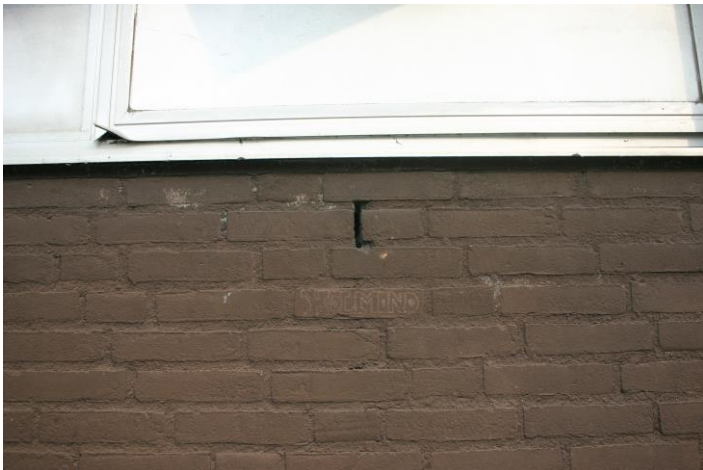
Figuur 4.2.3. Op circa 2 meter hoogte heeft het gebouw vele open stootvoegen.
