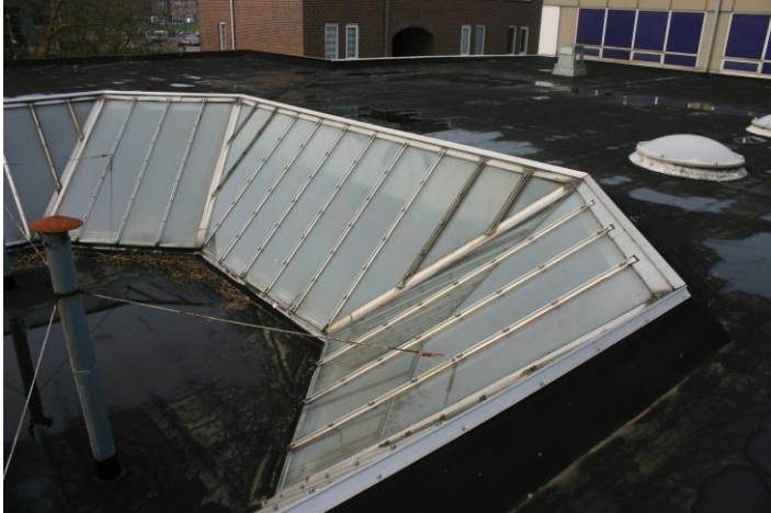
Figuur 4.2.1. Het gebouw heeft een bitumen dak.
