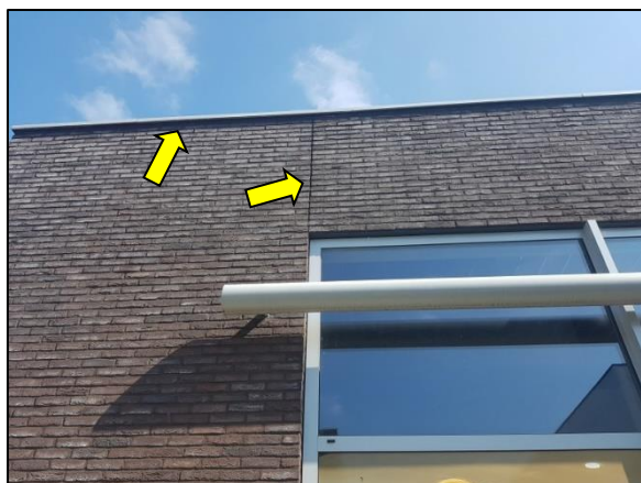
Figuur 14. Ruimte onder daktrim en in dilatatievoeg.
