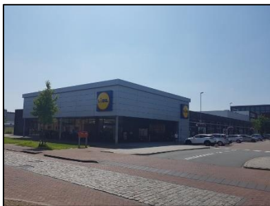
Figuur 3. Bebouwing binnen onderzoekslocatie, kijkrichting zuidoosten.
