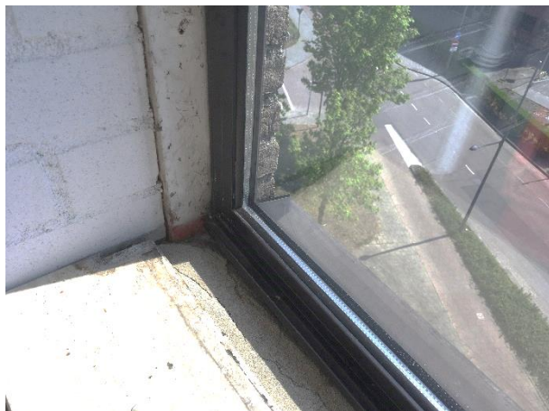
Verwijderde vensterbank aan binnenzijde raam
