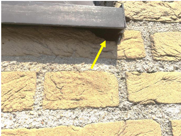
Plaats holte onder vensterbank raam 5 e verdieping zuidoostgevel gebouw fase 2 en endoscoopfoto in holte
