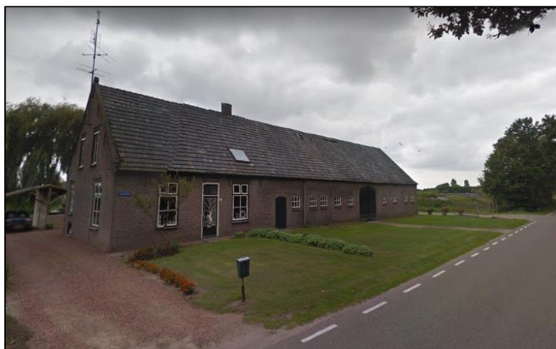
Huidige situatie plangebied (woonhuis) gezien vanaf de Heibergweg (Bron: Google Maps).
