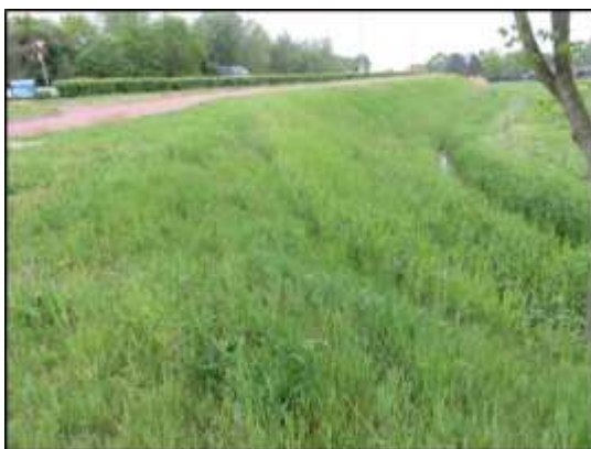
Foto 25. Berm en sloot ten westen van rotonde
