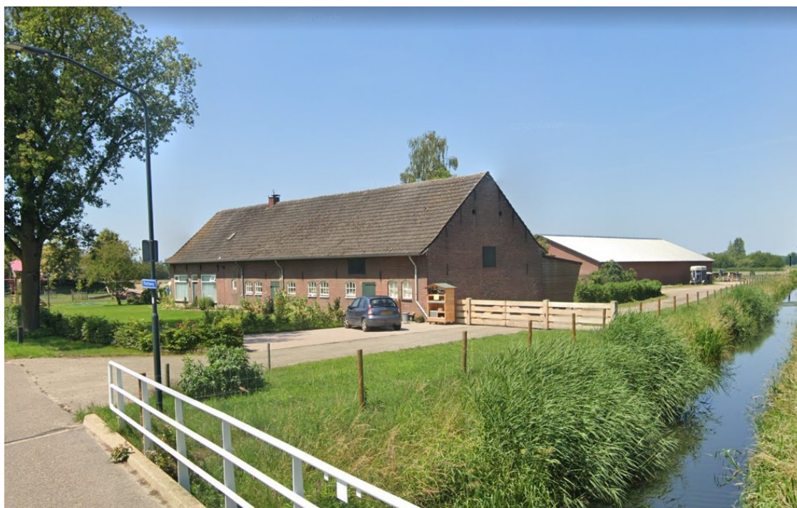
Figuur 9: Bedrijfswoning met bedrijfsgebouw, rechts de Oude Aa
