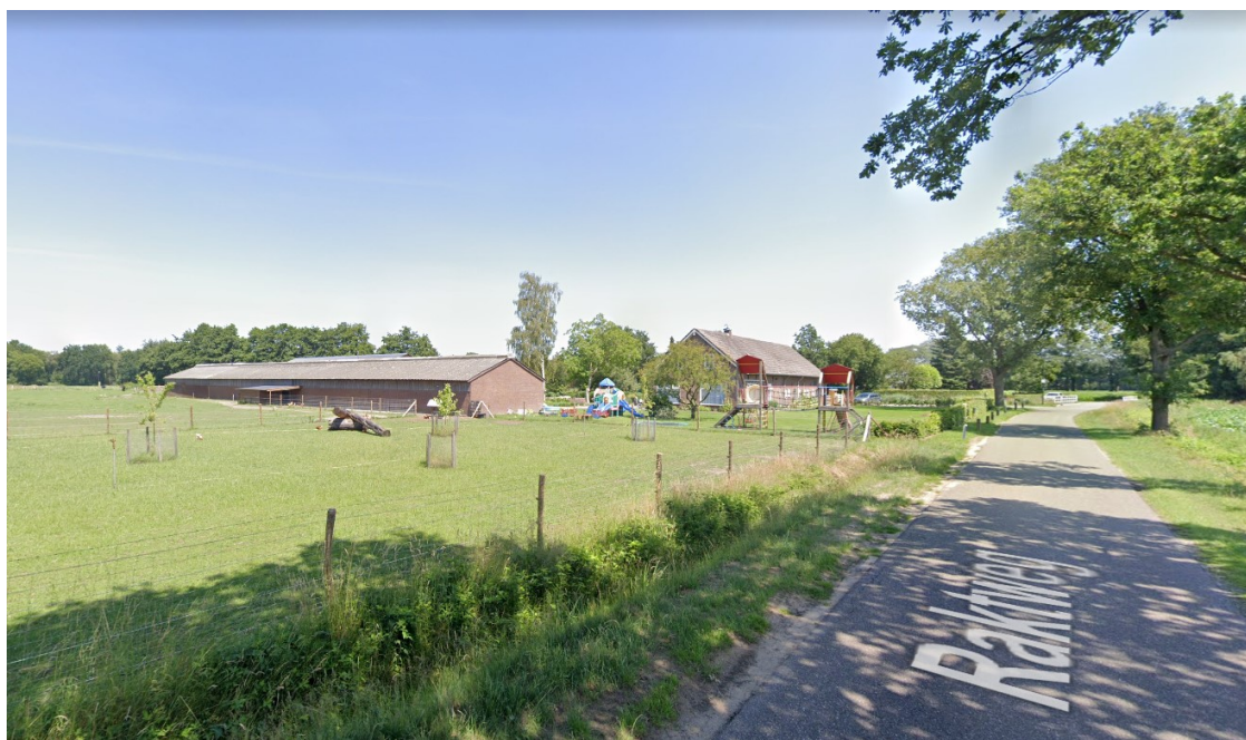
Figuur 10: Perceel gezien vanaf de westzijde
