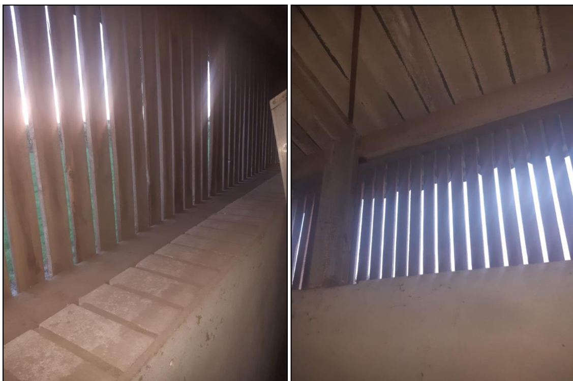
Figuur 27: open geveldelen van de voormalige stal
