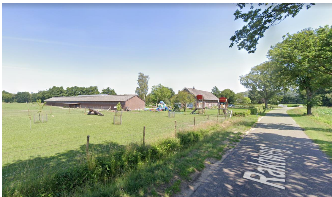
Figuur 10: Perceel gezien vanaf de westzijde
