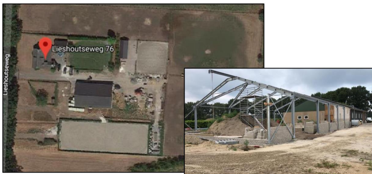
Afbeelding 5: Luchtfoto Lieshoutseweg 76 en stal in aanbouw
