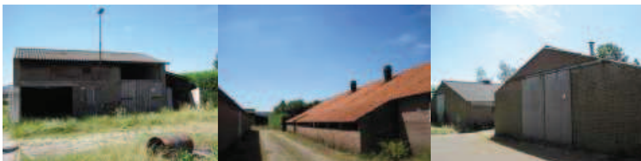
Foto 2,3,4 De vier te slopen stallen
