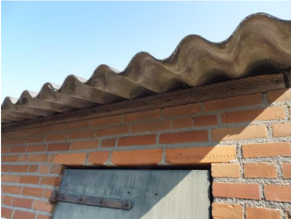
Met gaas afgedichte golfplaten in de varkensstallen.
