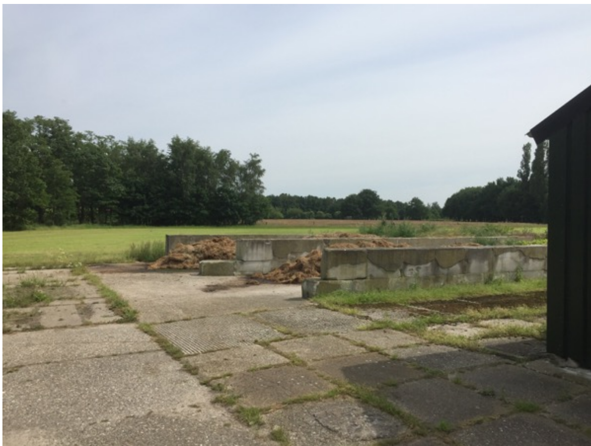
Figuur 11: Foto met daarop de bestaande en te slopen mest sleuf.
